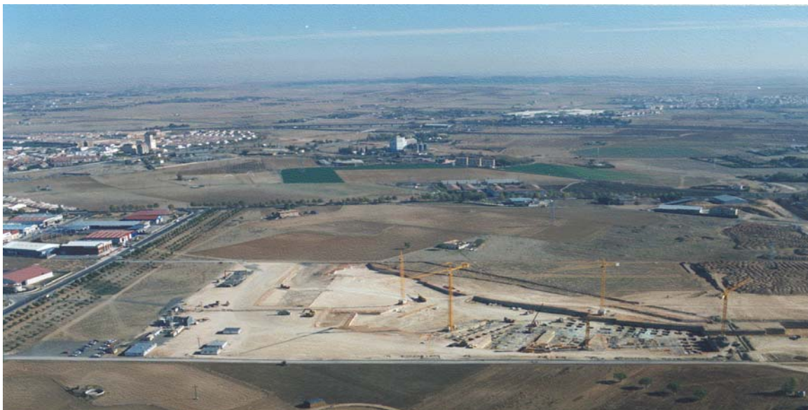
Construcción del hospital. Situación relativa Sector A-HERR.
