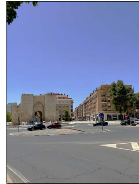
PUERTA DE TOLDO PLANTA BAJA + 4 + ATICO. EDIFICIO 1 Y EDIFICIO 2
