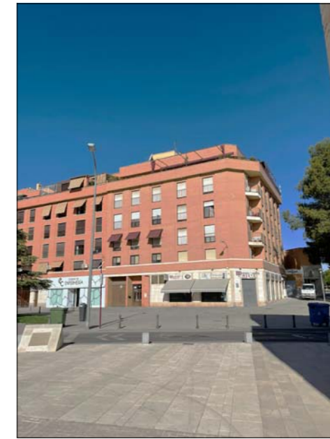
C/ PEDRERA BAJA, PUERTA DE TOLDO PLANTA BAJA + 4 + ATICO. EDIFICIO 1
