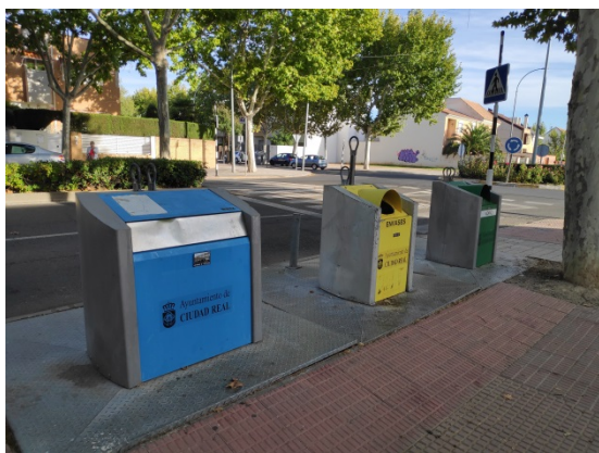
Foto 1: Contenedores soterrados inicio calle
