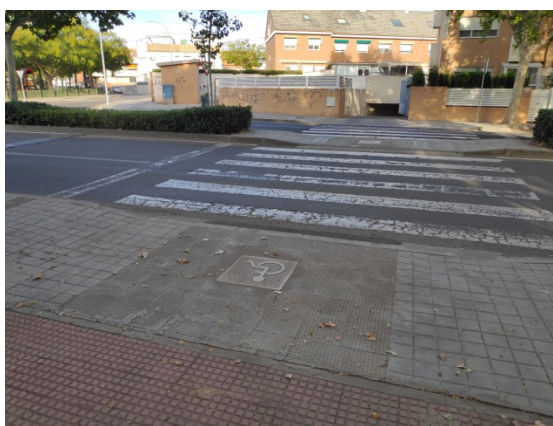
Foto 14: Extensión vado inferior al paso peatones
