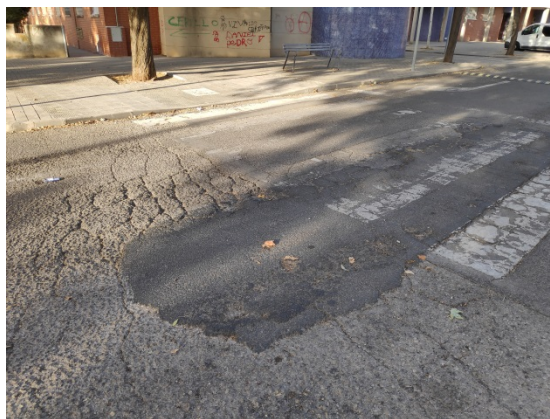
Foto 20: Señalización horizontal borrada
