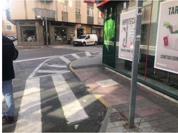
Foto 10. Vados peatonales sin cumplir normativa
