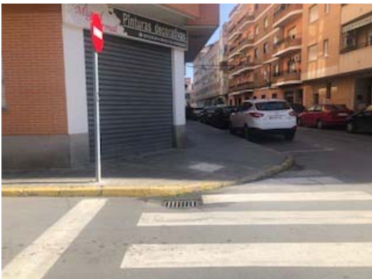
Foto 7. Paso de peatones mal alineados
