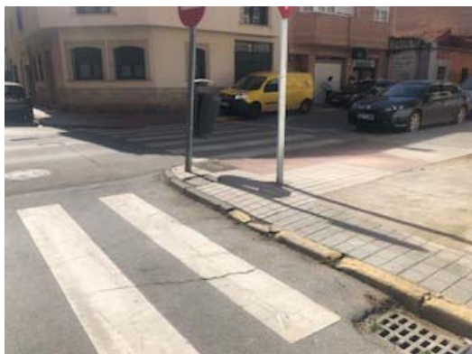
Foto 8. Paso de peatones sin cumplir normativa
