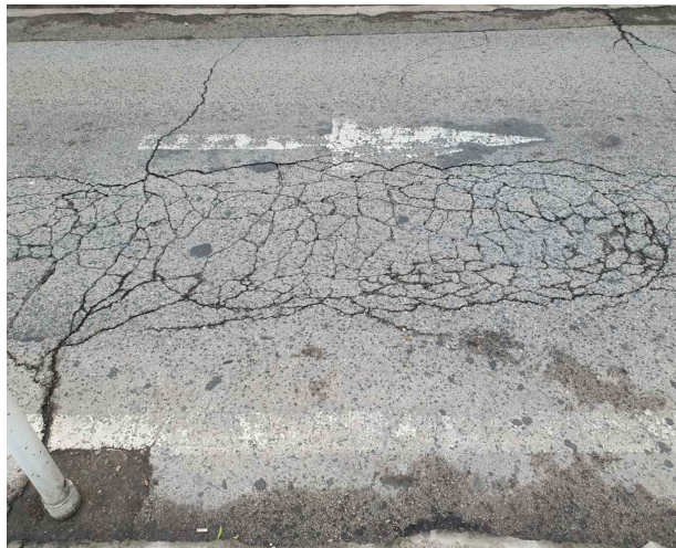
Tramo A_Vista L
