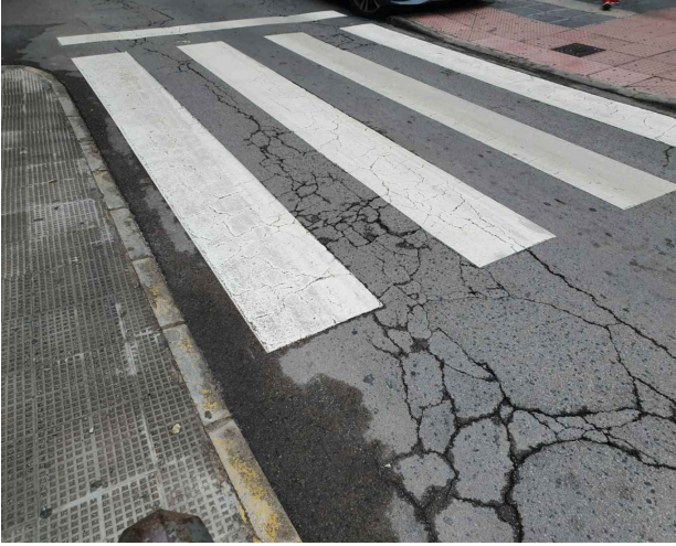
Tramo B_Vista J
