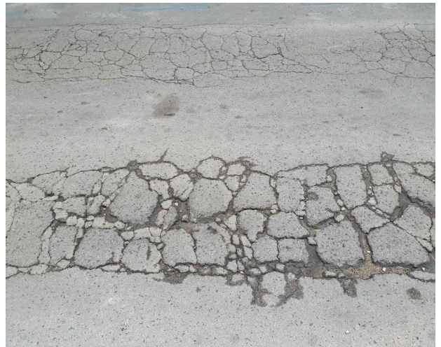
Tramo B_Vista H
