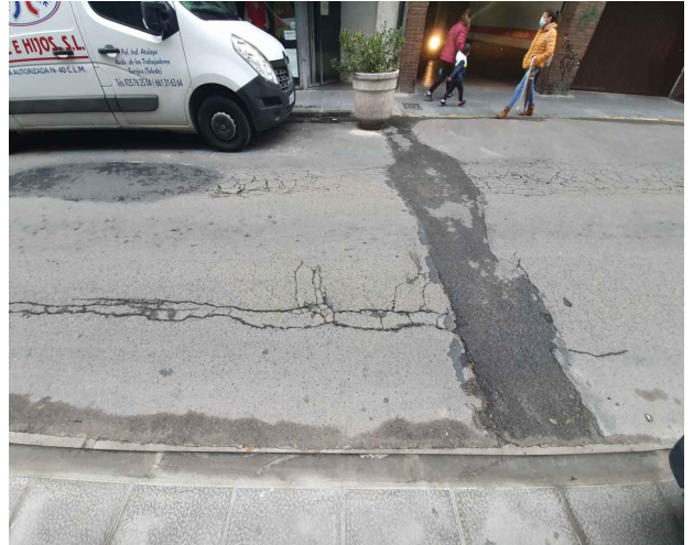
Tramo B_Vista G
