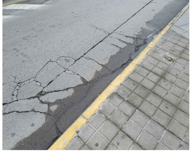
Tramo B_Vista K
