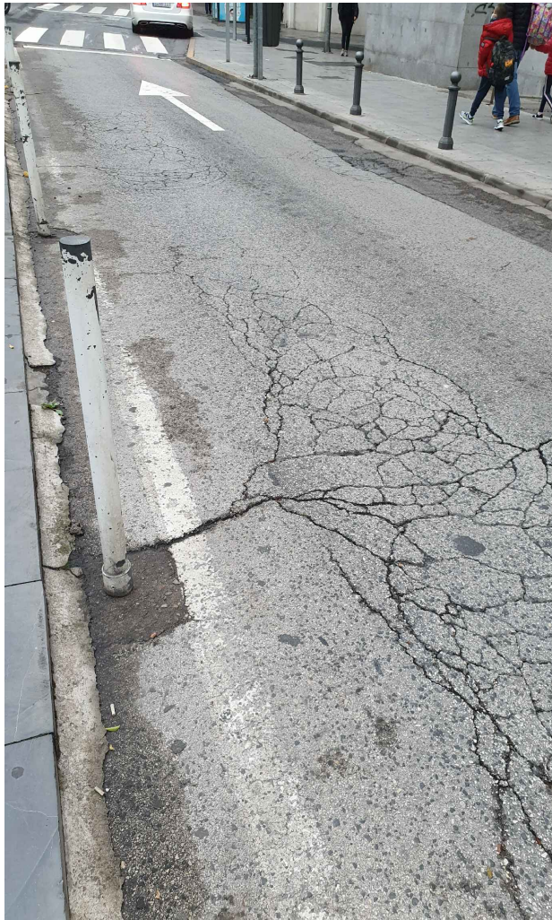
Tramo A_Vista J
