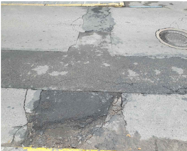
Tramo B_Vista E
