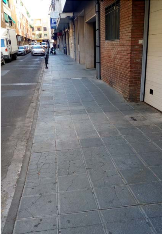
Diferentes acabados del pavimento de las aceras muy deteriorado.
