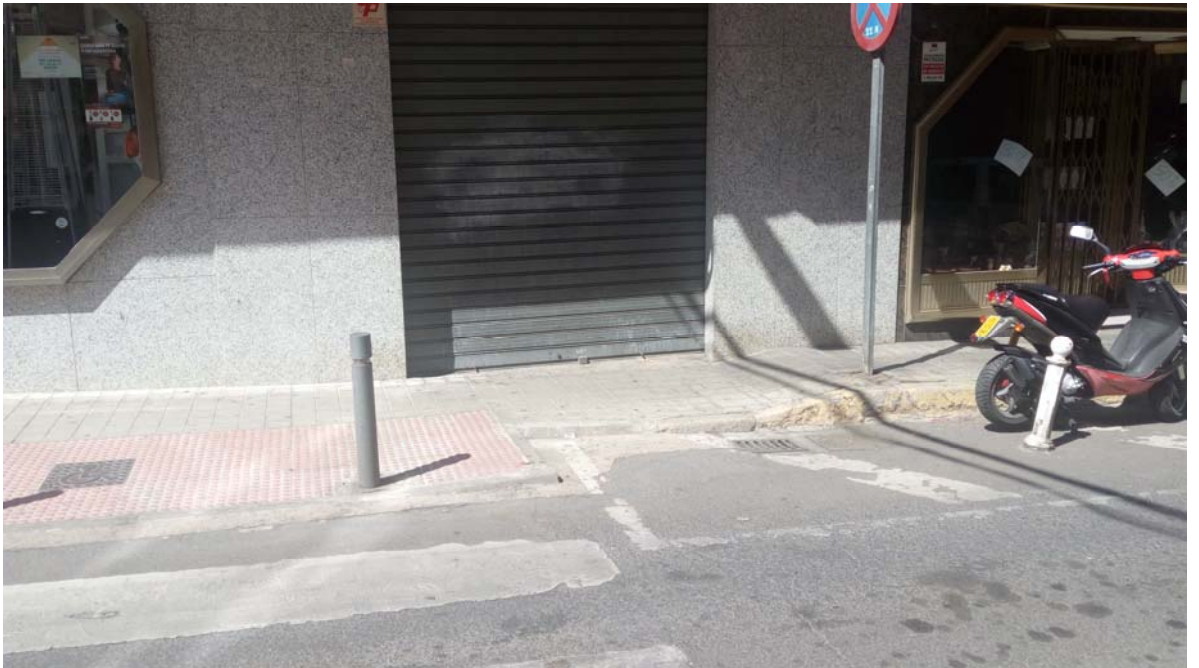
Paso estrecho y pendiente elevada. Señalización vertical obstaculizando el paso.
