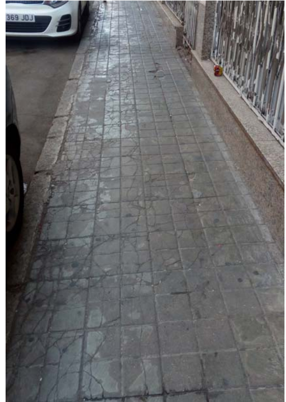
Diferentes acabados del pavimento de las aceras muy deteriorado.
